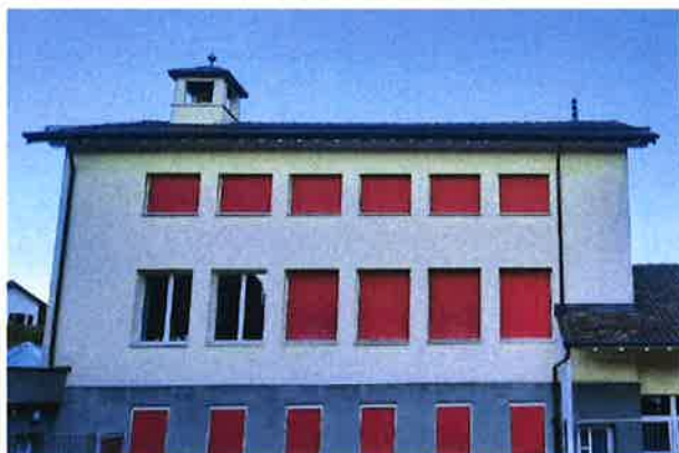
Le pan sud-est du bâtiment central, côté cour - le mieux exposé
